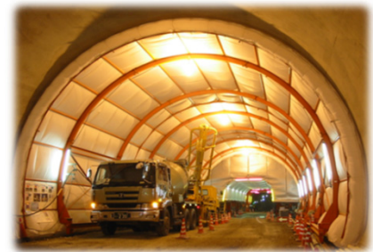
特許権を活用した「トンネル養生バルーン工法」(第1号案件)
